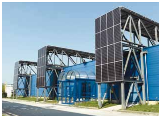
Vista dei tralicci dello stabilimento
